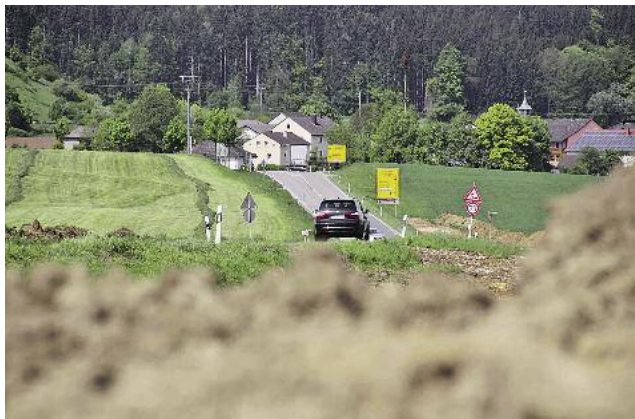
Startschuss: Die Bundesstraße 13 wird zwischen Rothenstein und Siebenkreuzhof verlegt. Die Trasse ist freigeräumt, aktuell laufen dort die archäologischen Untersuchungen. Die eigentlichen Bauarbeiten beginnen am 15. Juni. Foto: Stephan
